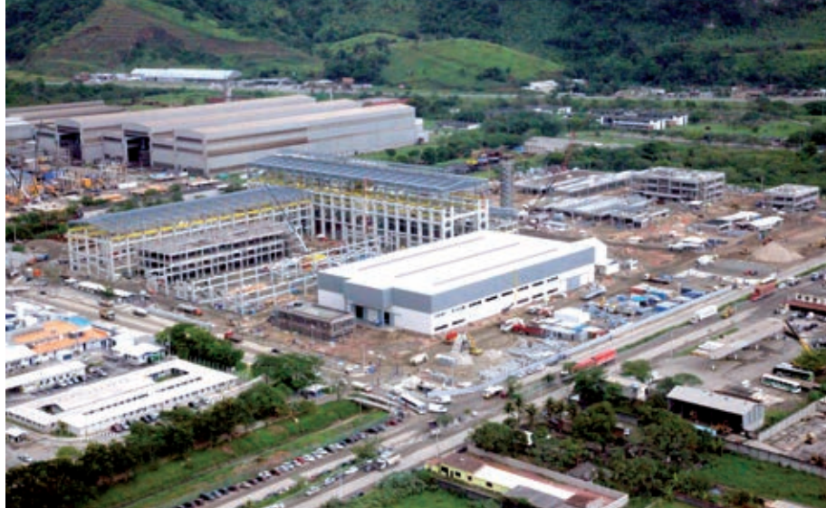
Obra extensa de engenharia, Prosub já constrói os primeiros submarinos brasileiros
