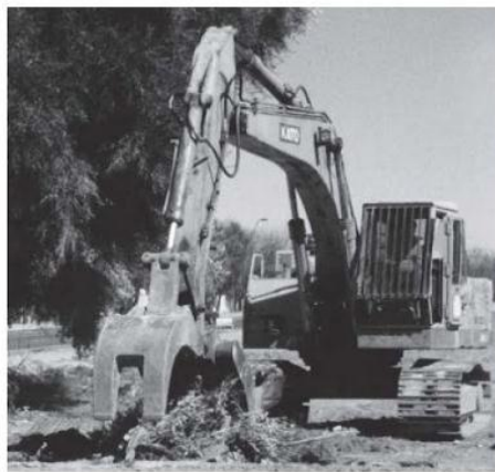
(a) Retroscavadeira hidráulica com garras para limpeza do terreno
