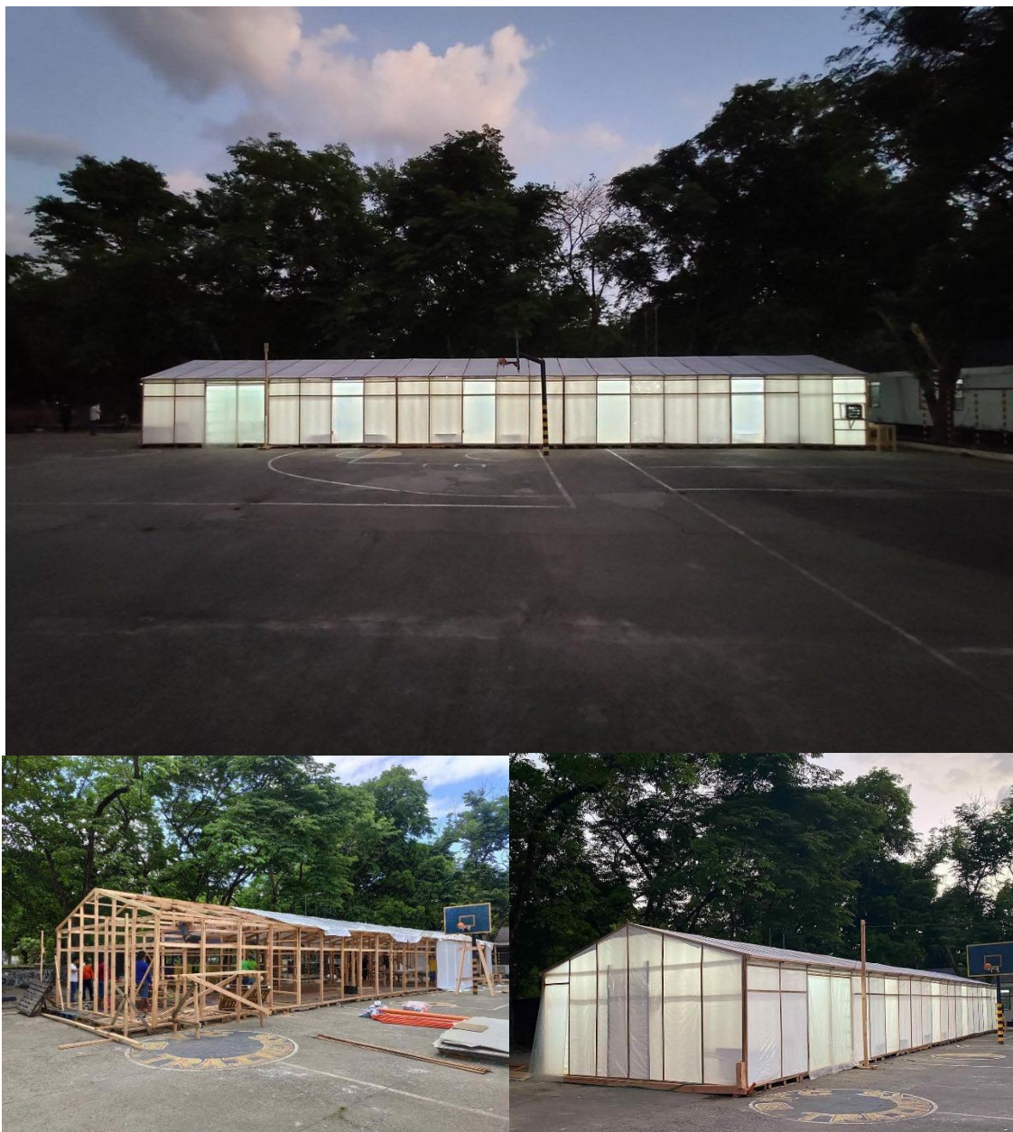
Figura 66- Pavilhão temporário e processo de montagem. Fonte: HARROUK,2020a
