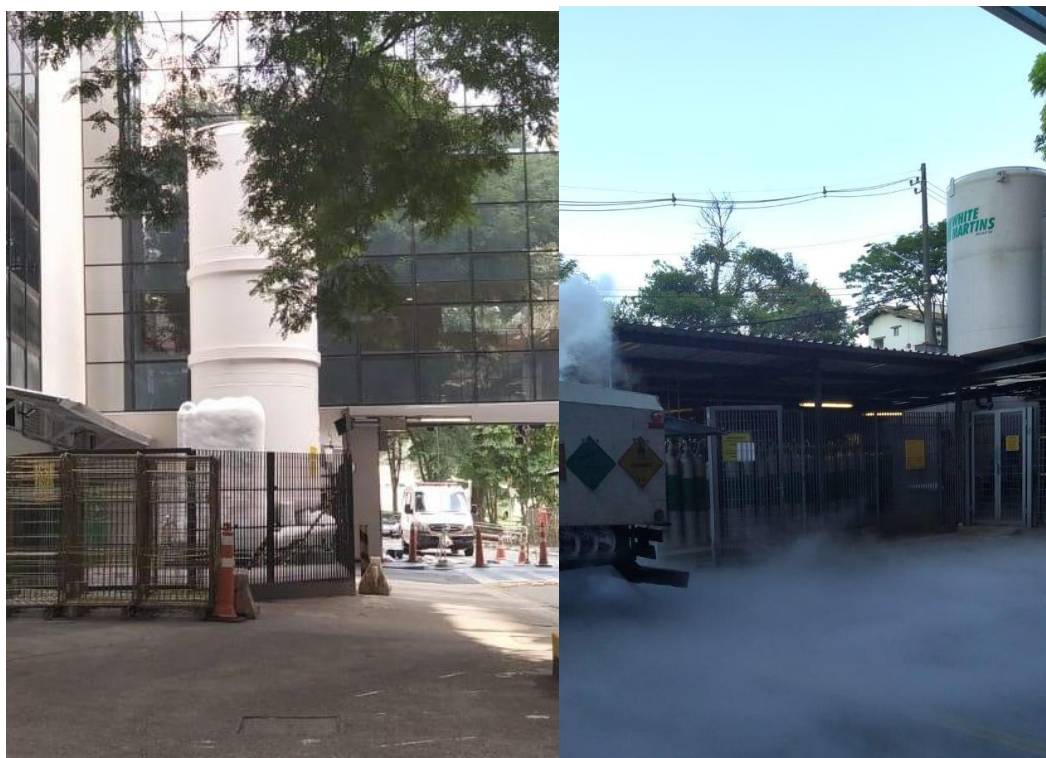
Figura 90 - Novos tanques maiores de oxigênio e abastecimento de um deles. Fonte: Autora
