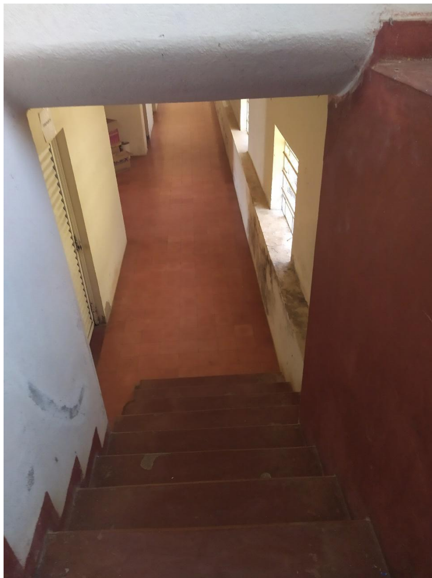
Figura 103 - Escada de acesso ao subsolo, onde ficam a lavanderia, depósitos e abrigo de resíduos. Fonte: Autora.
