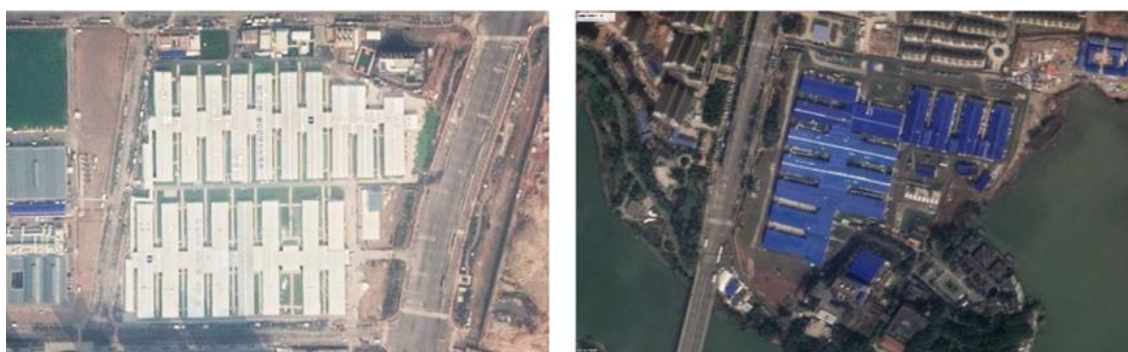
Figura 60- À esquerda, vista área do Hospital Lishenshan e à direita do Hospital Huoshenshan. Fonte: Google Earth 2020
