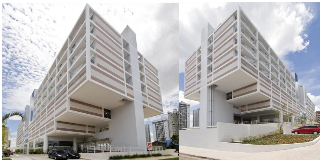
Figura 42-Fachadas do hospital. Fonte: Galeria da Arquitetura. https://www.galeriadaarquitetura.com.br/projeto/zanettini-arquitetura_/hospital-e-maternidade-sao-luiz/266
