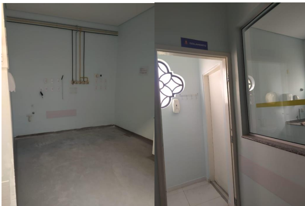
Figura 114 - Nova UTI em obras. Fonte: Autora.
