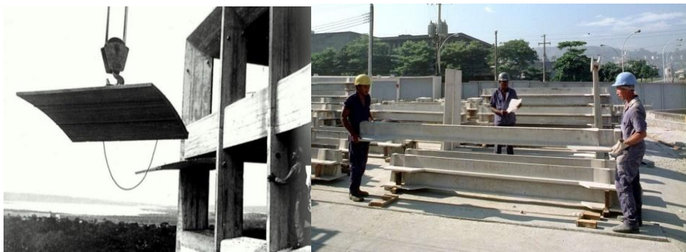
Figura 17- Levantamento de peça pré-fabricada da obra DISBRAVE em Brasília e Fábrica de Escolas, componentes em argamassa armada para saneamento básico, Rio de Janeiro RJ. Fotografia : Marcel Gautherot. Fonte : Archdayli e https://vitruvius.com.br/index.php/revi
