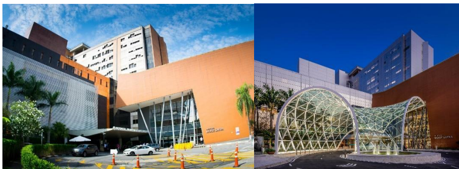
Figura 45-Antes e depois do Retrofit Fachada Hospital Israelita Albert Einstein, São Paulo. Fonte: https://www.metropoles.com/brasil/hospital-albert-einstein-registra-104-de-ocupacao-em-todos-os-leitos e arquivo pessoal da autora.
