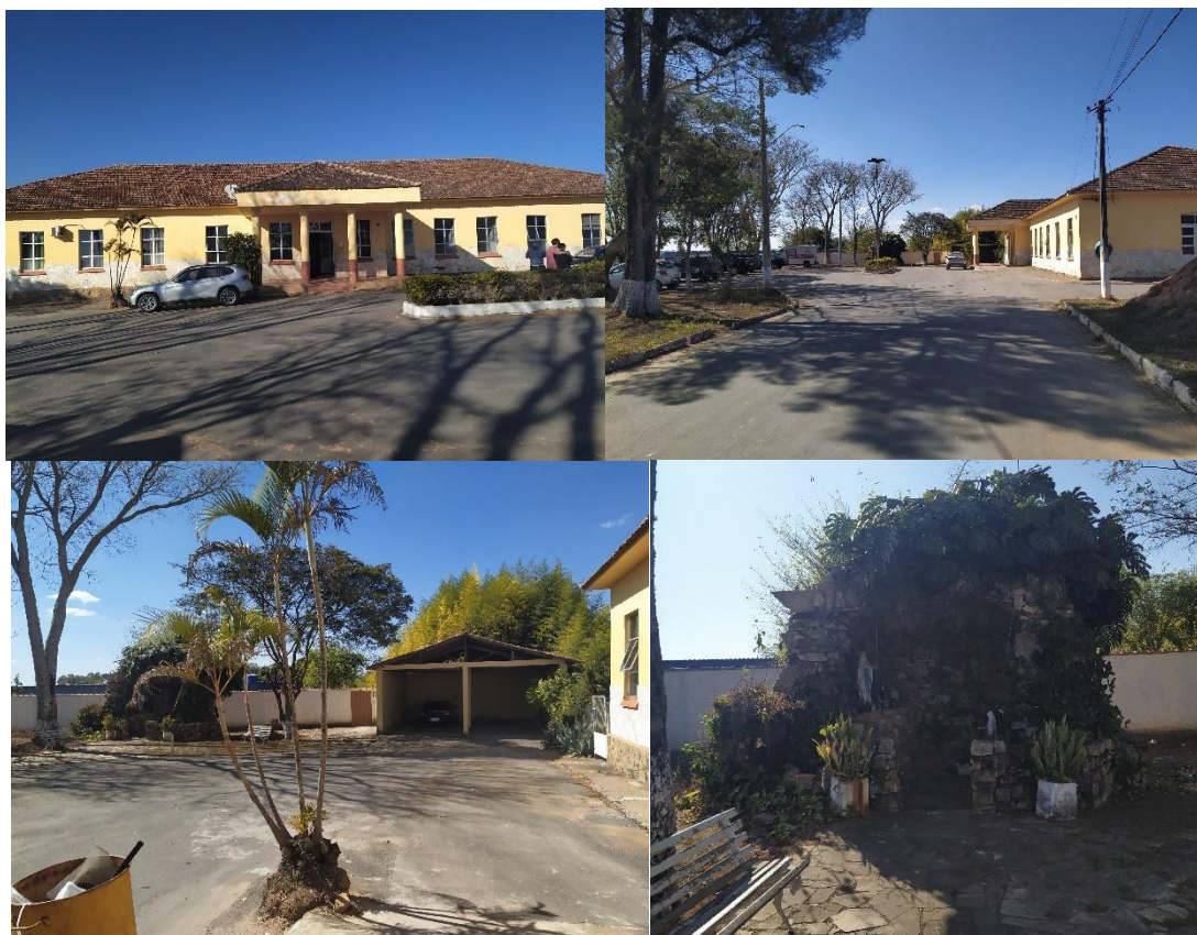
Figura 101- Fotos da área externa e fachada do hospital. Fonte: Autora.
