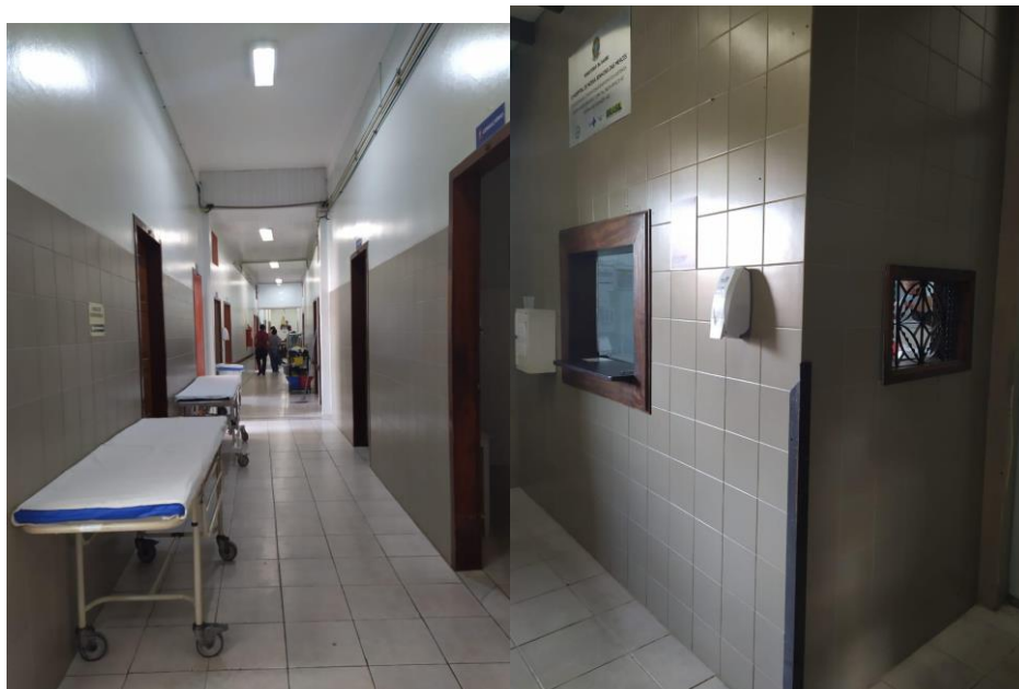
Figura 118 – Uso de revestimentos mais antigos e escuros no Pronto atendimento. Fonte: Autora.
