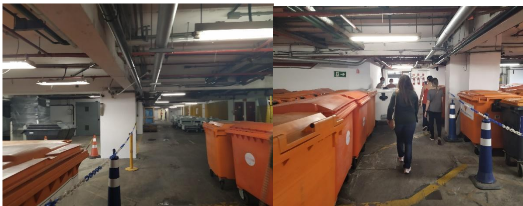
Figura 85 - Andar de Garagem sendo utilizado para equipamentos quebrados e armazenamento de resíduos. Fonte : Autora
