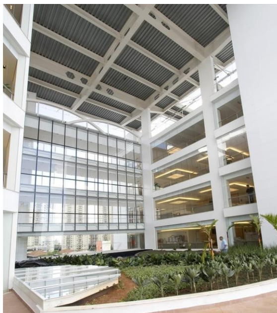
Figura 44-Átrio visto do 4º pavimento e circulação das passarelas transparentes. Fonte: Galeria da Arquitetura. https://www.galeriadaarquitetura.com.br/projeto/zanettini-arquitetura/_hospital-e-maternidade-sao-luiz/266
