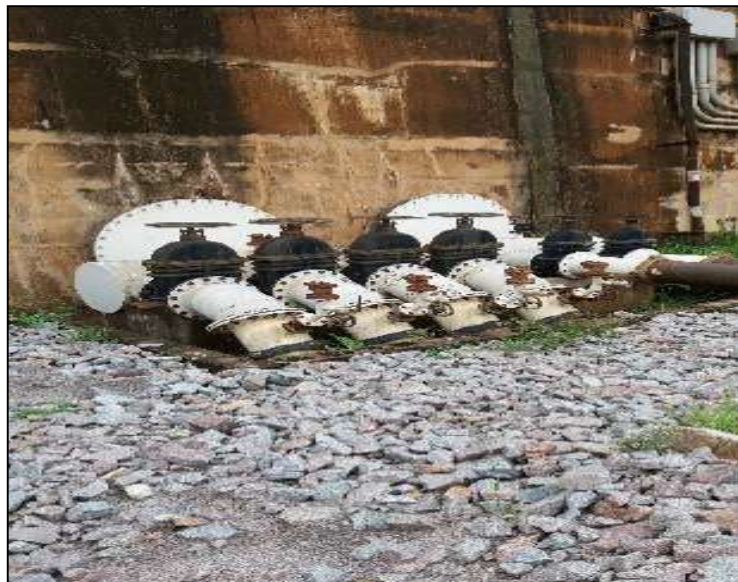
Figura 14: Captação 2, visão aproximada
