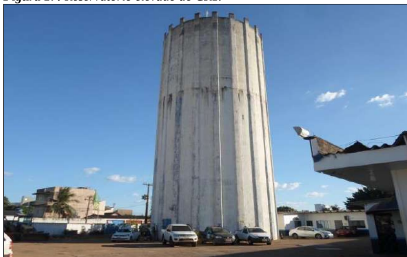
Figura 17: Reservatório elevado do CR1.
