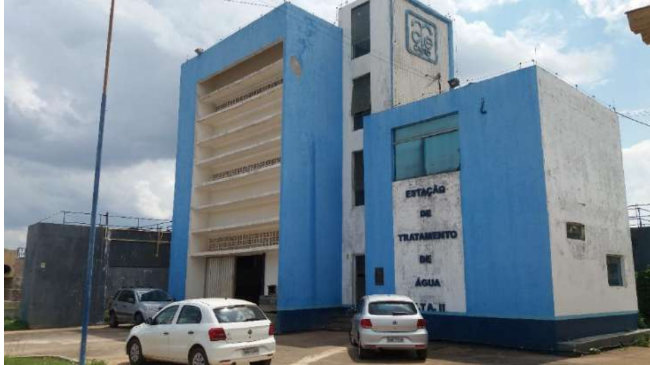
Figura 23: Fachada principal do prédio da ETA
