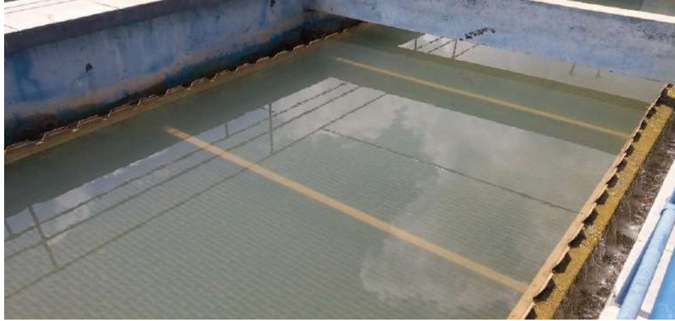
Figura 27: Decantador
