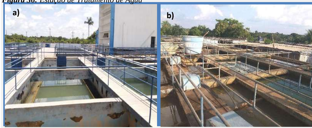
Figura 36: Estação de Tratamento de Água
