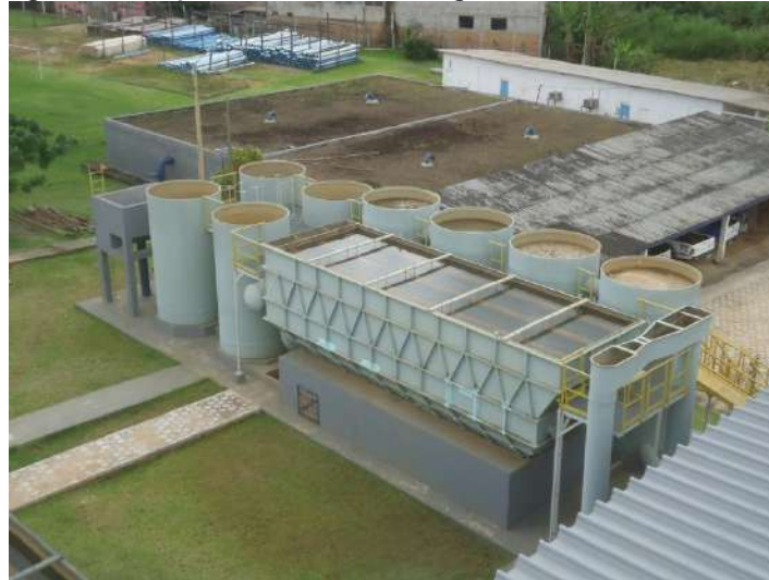
Figura 4: Estação de Tratamento de Água de Jaru
