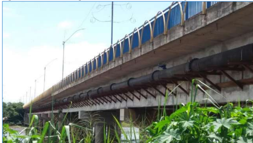
Figura 3: Adutora de água tratada, DN 500 mm, sob a ponte do Rio Machado
