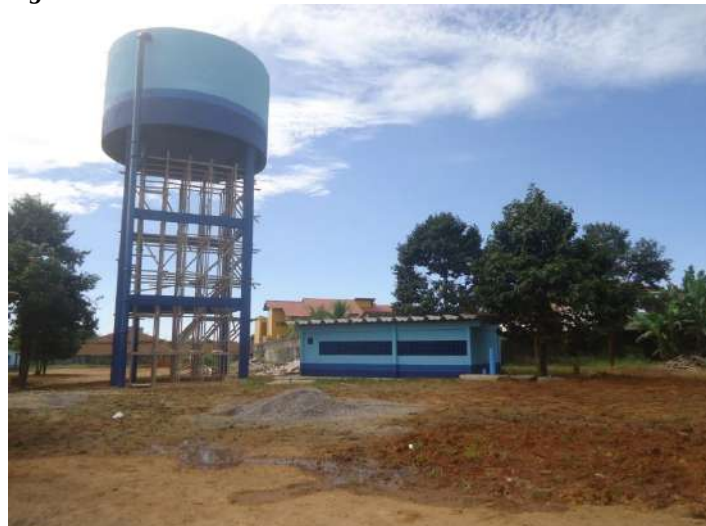
Figura 5: Reservatório elevado de 250 m 3
